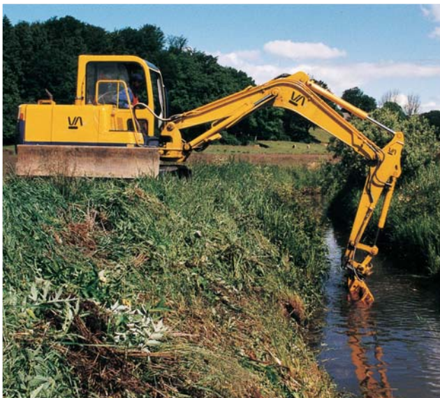
Grødeskæring i bundløs kanal med mejekurv.
